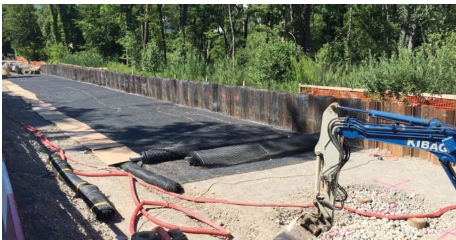
Abbildung 3: Verlegte Fortrac-Geogitter der 1. Baustufe. Rechts über der Spundwand hängend die Geogitter in Querrichtung für den Rückumschlag. Links unter den Abdeckplatten die aufgerollten Geogitter in Querrichtung für die 2. Baustufe.
