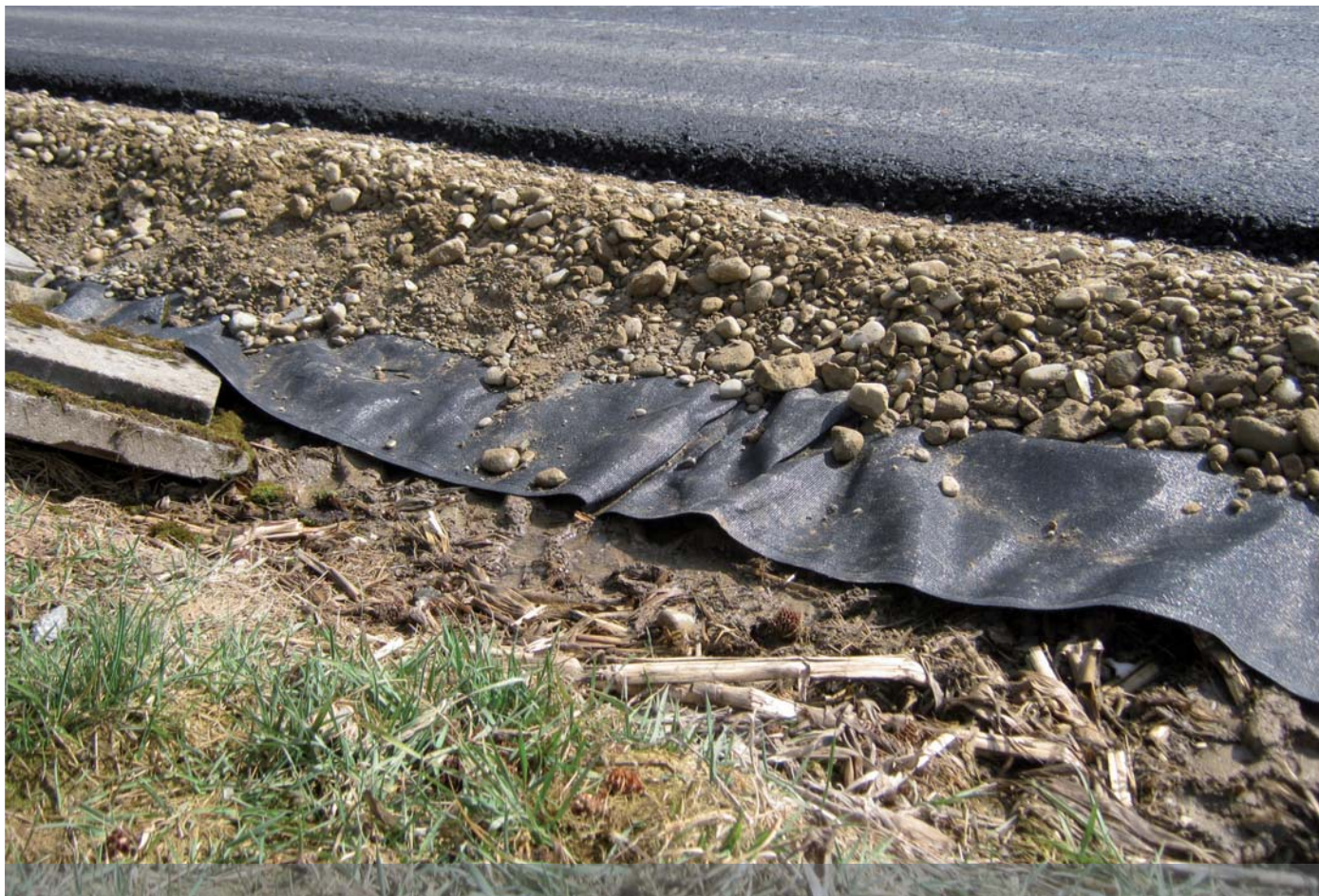
Die Baustrassen wurden wegen der Staubentwicklung streckenweise mit einer Asphaltdecke ausgeführt.
