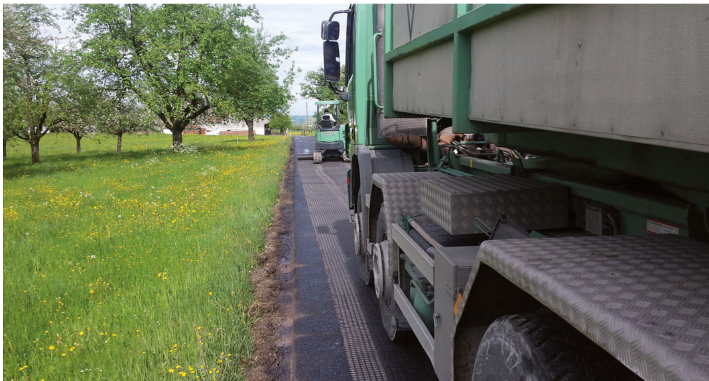
Mischgut-Lkw auf der Hatelit-Sanierungsschicht.
