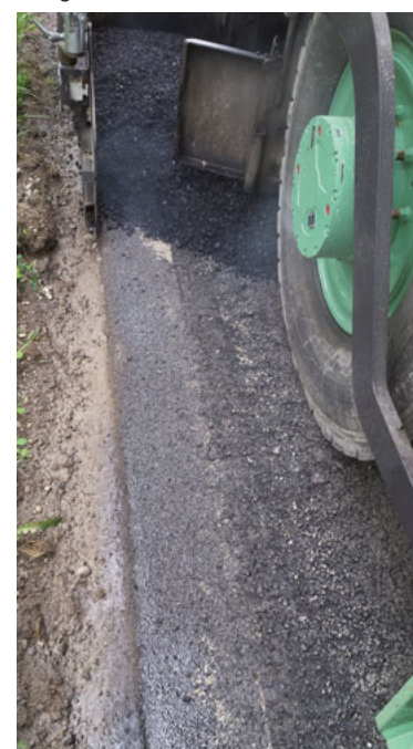
Einbau des Mischguts durch den Fertiger auf das Hatelit.
