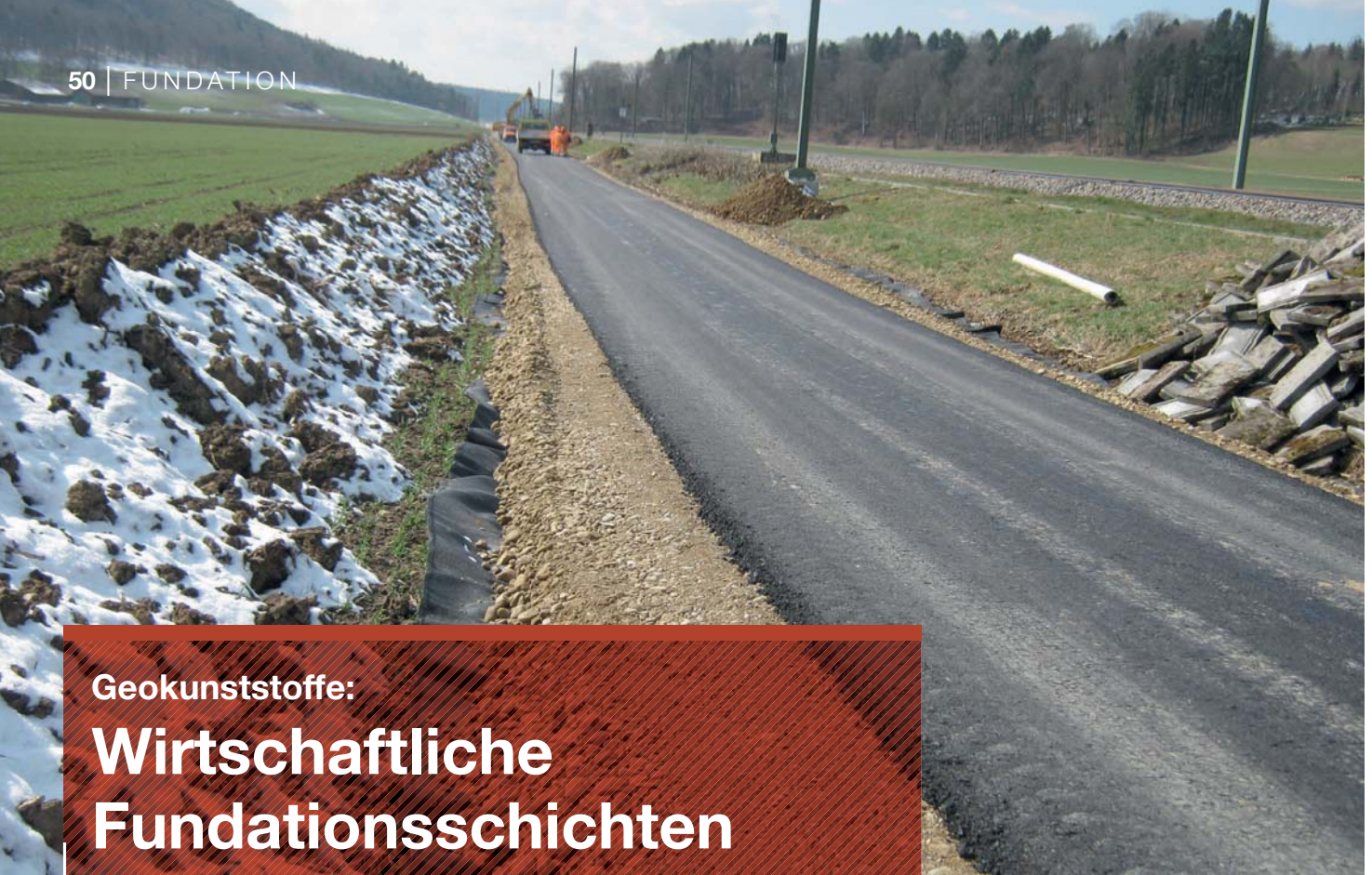
Temporäre Baupiste (mit Bändchengewebe), Doppelspurausbau Erzingen-Beringen.
