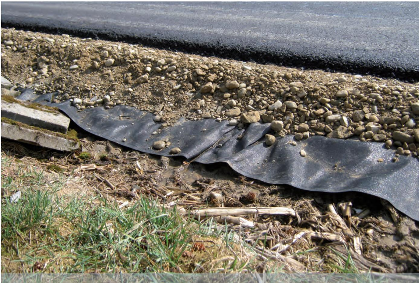
*Piste de chantier recouverte avec Propex® 7063 en tant que couche de séparation et de renforcement*
