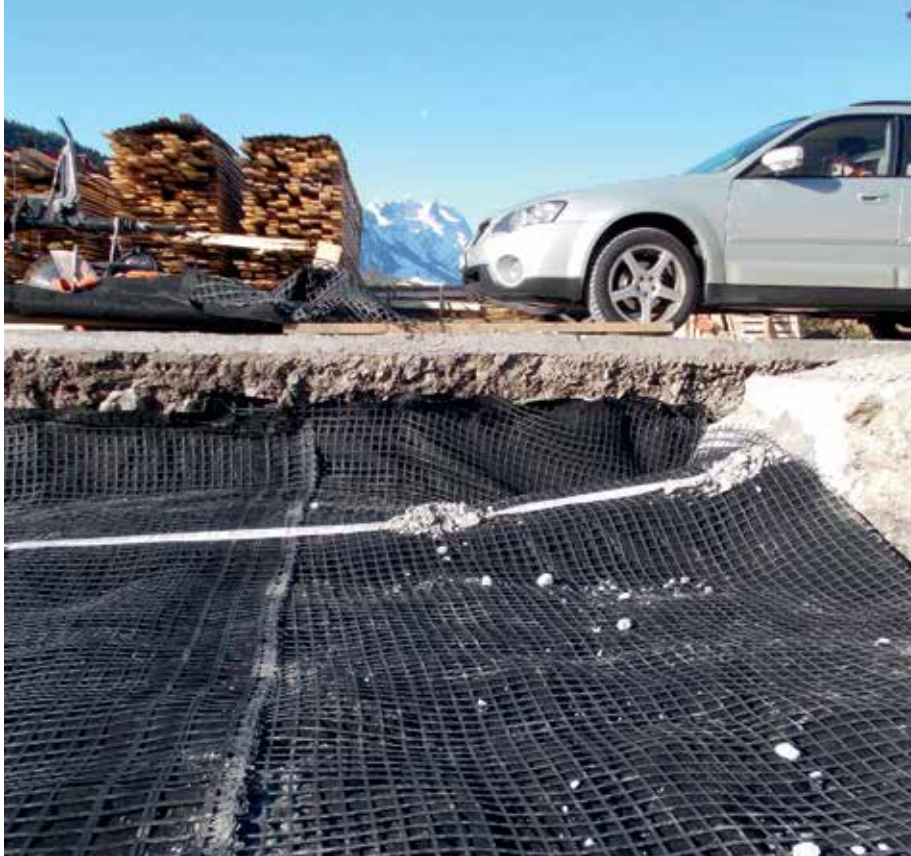
Couche supérieure de géogridde Fortrac 110/110-30T.
