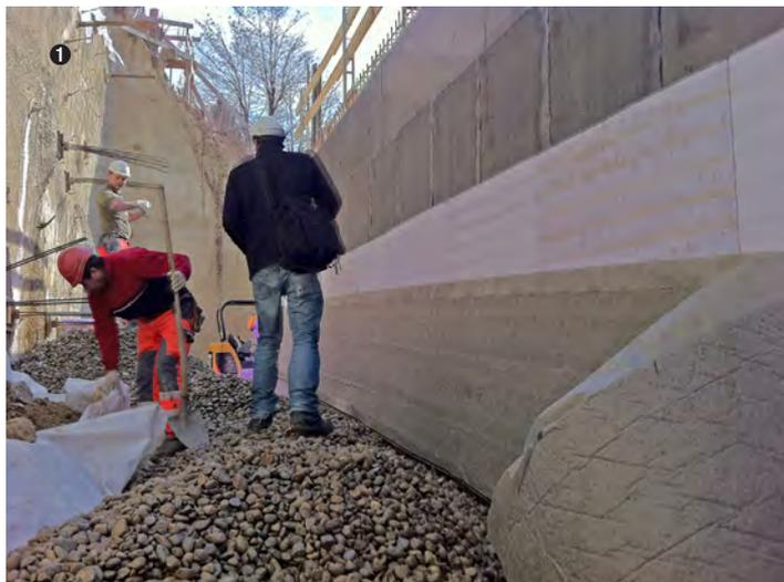
❶ A gauche, le talus rocheux stabilisé, à droite, l'isolation avec des nattes Enkadrain sur tout le périmètre ; le mur de façade est ainsi à la fois isolé contre les bruits et protégé contre les eaux stagnantes.
