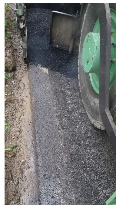
Pose de l'enrobé sur HaTelit par le finisseur
