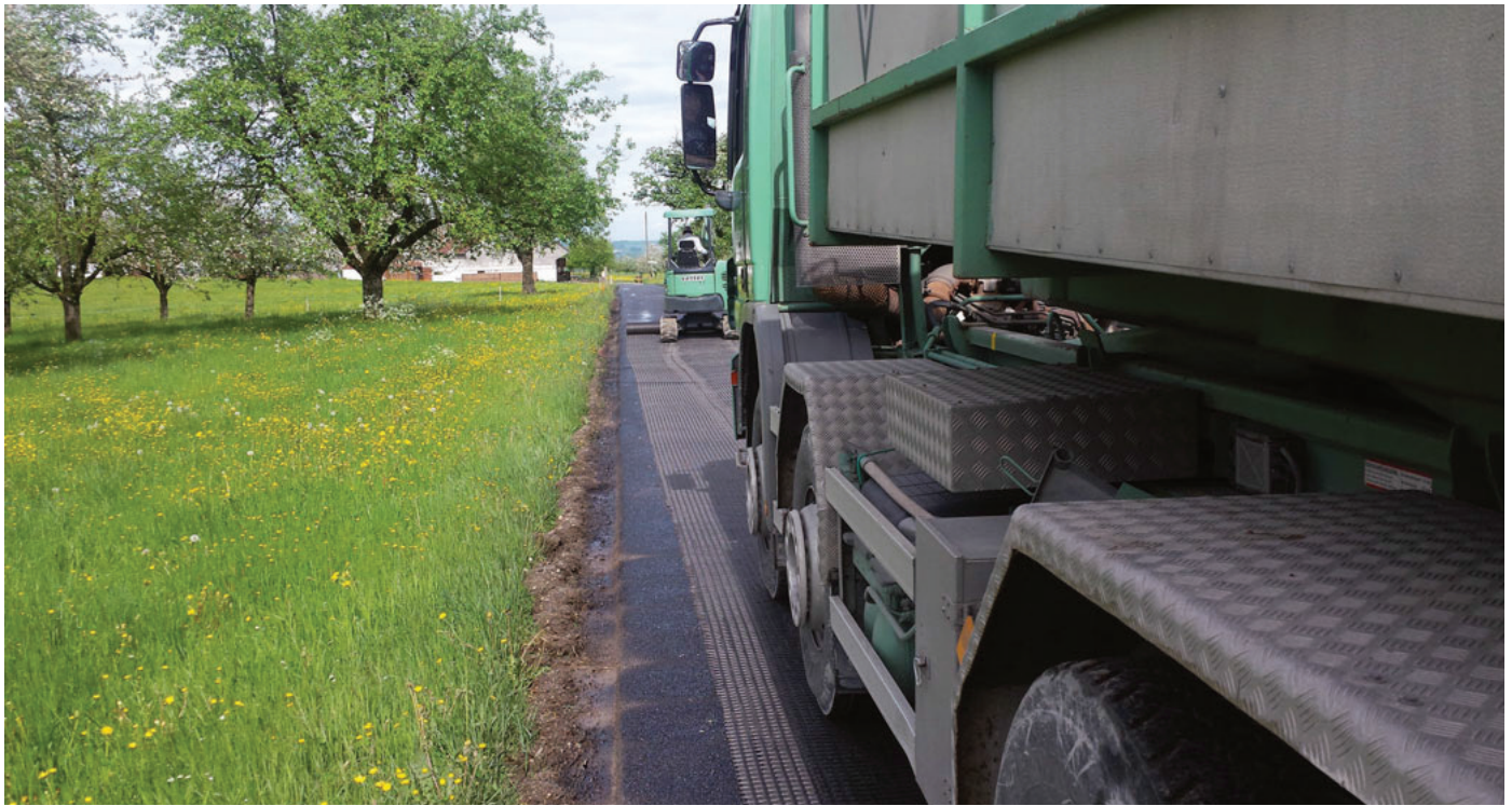
Camion d'enrobé sur la couche de rénovation HaTelit.
