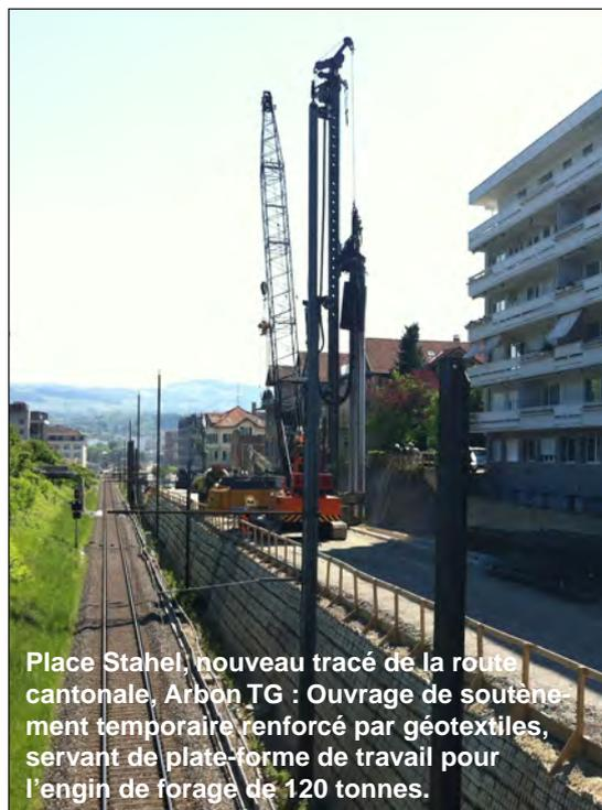
Place Stahel, nouveau tracé de la route cantonale, Arbon TG : Ouvrage de soutènement temporaire renforcé par géotextiles, servant de plate-forme de travail pour l'engin de forage de 120 tonnes.
