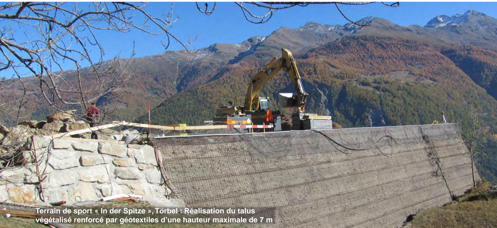
Terrain de sport « In der Spitze », Törbel : Réalisation du talus végétalisé renforcé par géotextiles d'une hauteur maximale de 7 m
