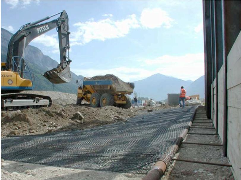
Abb. 8.4: Einbau der Geogitter Bewehrung
