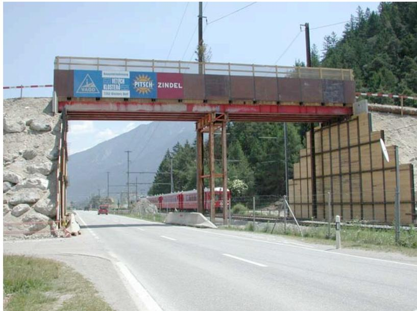
Abb. 8.1: Temporäre Brücke mit Geogitter rückverankerten Widerlagern
