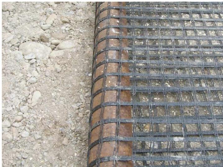
Abb. 8.3: Fortrac<sup>®</sup>-Geogitter knickfrei und sauber an Ankerrohr anliegend
