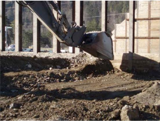
Abb. 8.5: Ausbau der Geogitter
