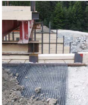
Blick auf die aufgelegten Brückenträger
