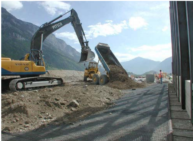
Überschütten der ersten Fortrac®-Geogitterlage. Der saubere Einbau ist sehr entscheidend wie gut eine Vorspannung aufgebracht werden kann.
