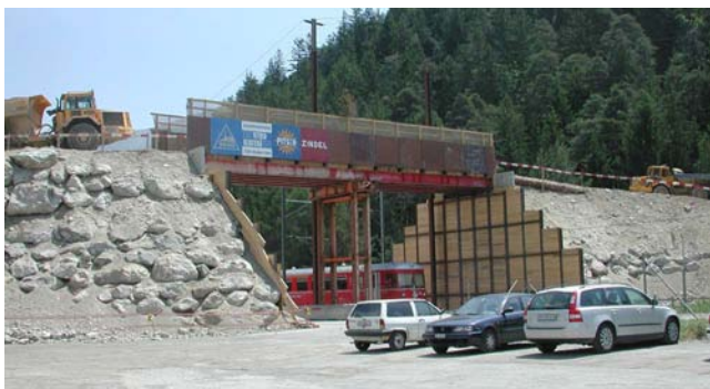
Fertige Brücke unter Dauerbelastung
