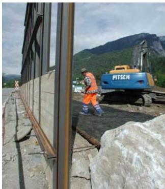
En plus des caractéristiques appropriées de force de traction et d'allongement, la grande flexibilité est décisive pour le choix de la géogrille.
