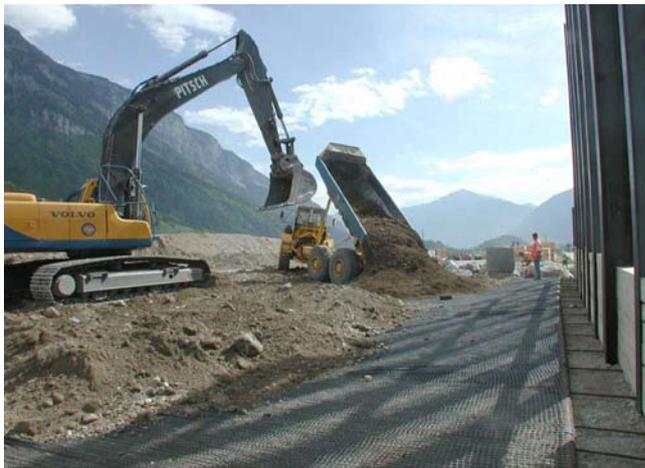
Mise en place du remblayage sur la première couche de géogrille Fortrac®. Une pose soignée est essentielle pour la qualité de la prétension appliquée.
