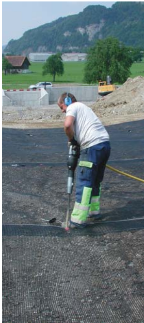
Bild 7: «Schutzmassnahmen Kniri West», Stans, Verankerung der Fortrac®-Gitter.
