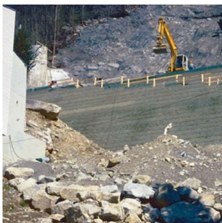
Bild 4: «Schutzdamm gegen Schuttmassen und Steinschlag», Gondo, ausgeführt 2002.
