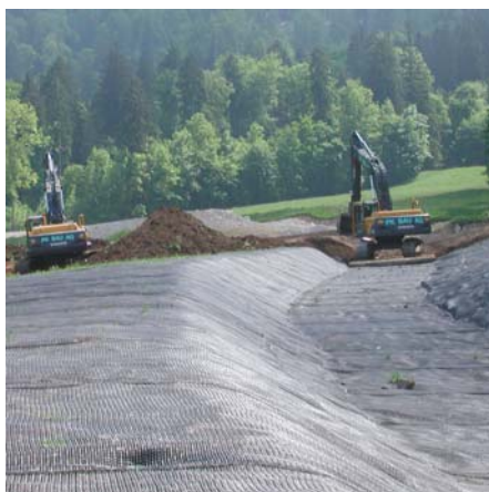
Bild 2: «Schutzmassnahmen Kniri West», Stans, ausgeführt 2007-2009.
