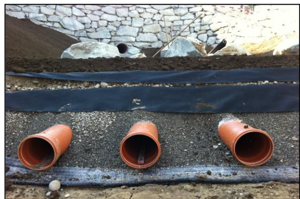
Abb. 6: Retentionsfilterbecken
