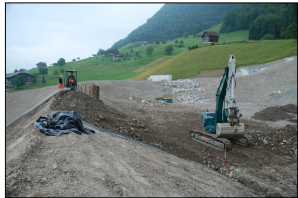
Abb. 7: Hochwasserrückhaltebecken
