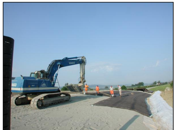
Abb. 9: Deponie Oberflächenabdichtung
