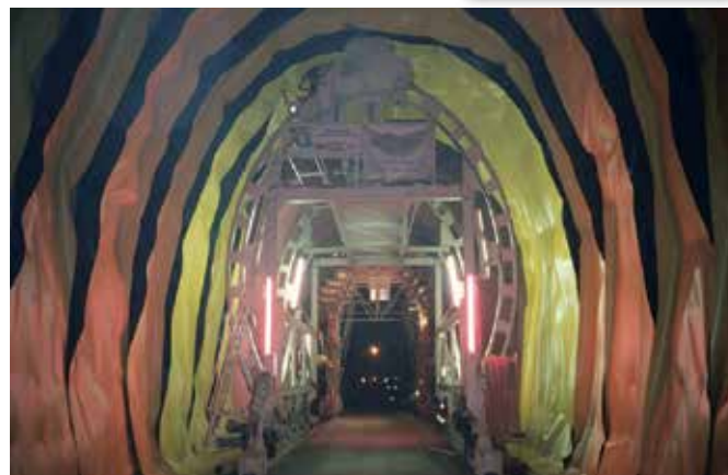
BLS Alptransit AG, Lötschbergbasistunnel, Los Mitholz
