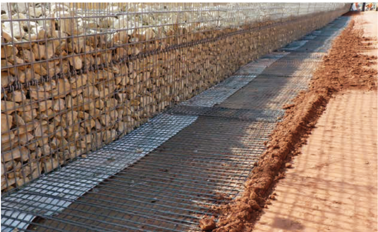
Rückverankerte Gabionenwand (A3 Höhe Haseltal, Deutschland)
