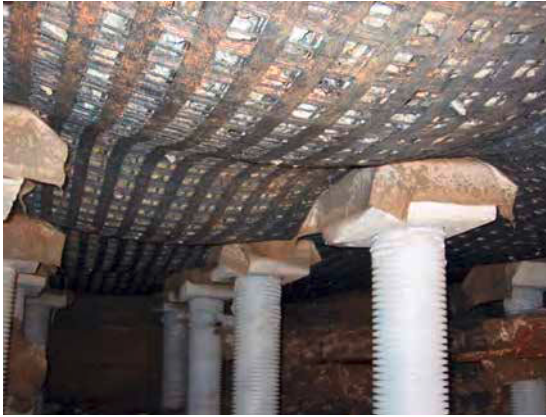
Membranwirkung bei aufgeständerten Polstern (Railway Bidor-Rawang, Malaysia)
