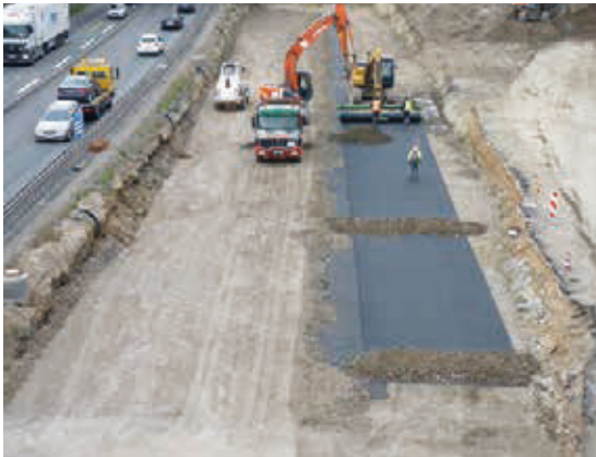
Verlegung einer Erdfallsicherung (Bochumer Westkreuz (A 52), Deutschland)
