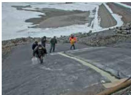
Les chevauchements dans les bassins doivent toujours être étanchéifiés à l'aide de poudre. Les chevauchements dans les cours d'eau n'ont généralement pas besoin d'une étanchéification spéciale, mais les nattes doivent être posées de l'aval vers l'amont.
