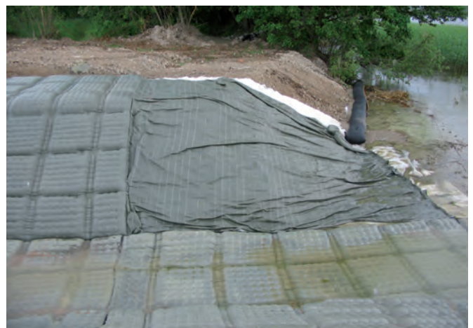
Einbau (Befüllte und unbefüllte Abschnitte) (3)
