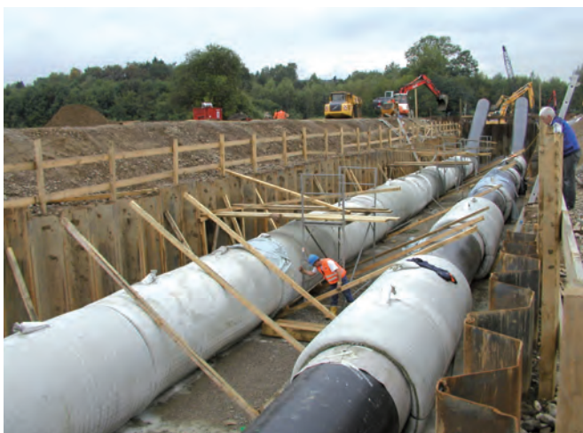
Incomat® Standard zur Ummantelung und Auftriebssicherung eines Dükers
