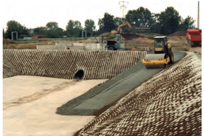
Speicherbecken mit Incomat® Crib nach Verfüllung des Gitterrasters mit Boden
