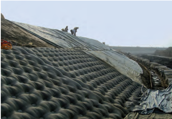
Einbau von Incomat® FP (1)
