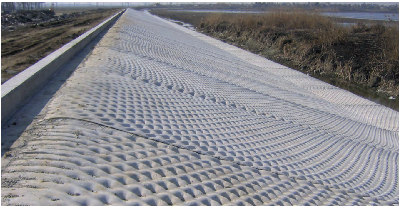
Böschungssicherung mit Incomat® FP
