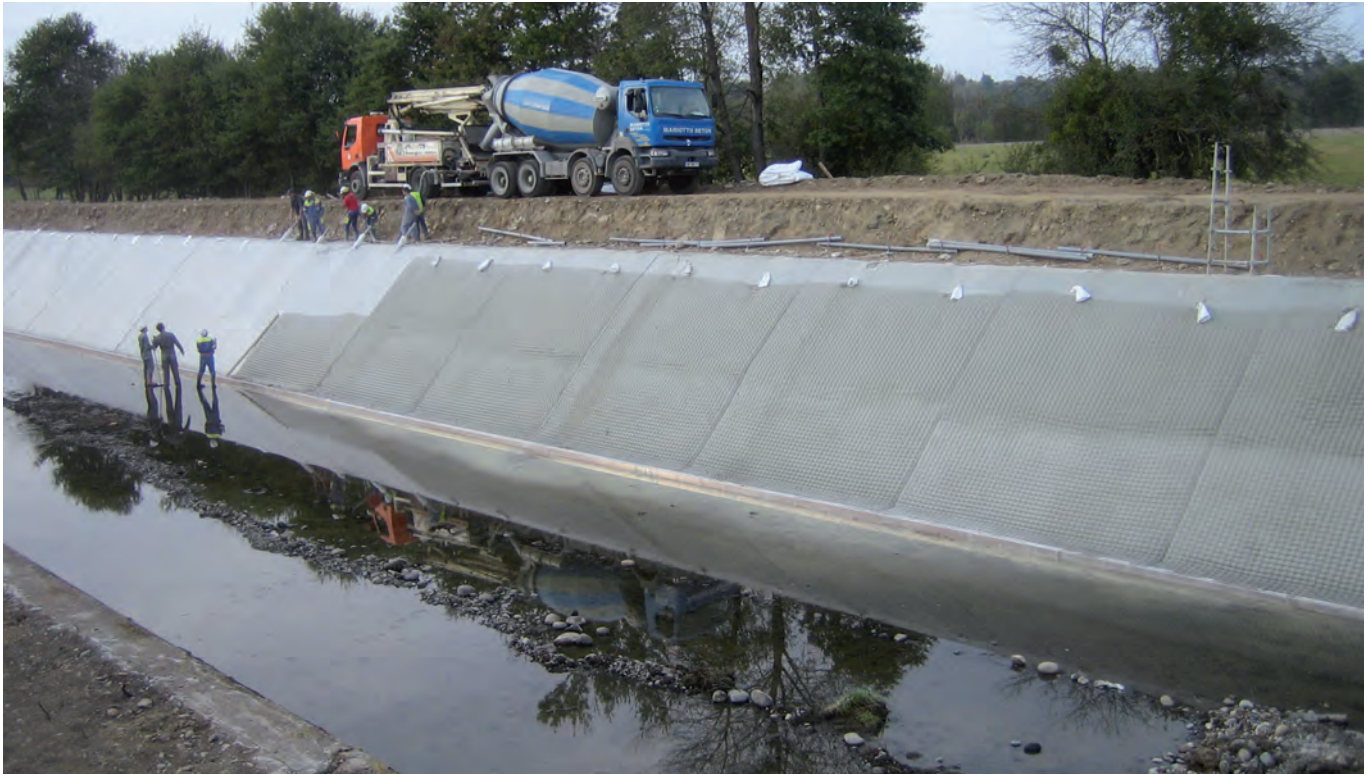
Abschnittsweiser Befüllprozess von Incomat®
