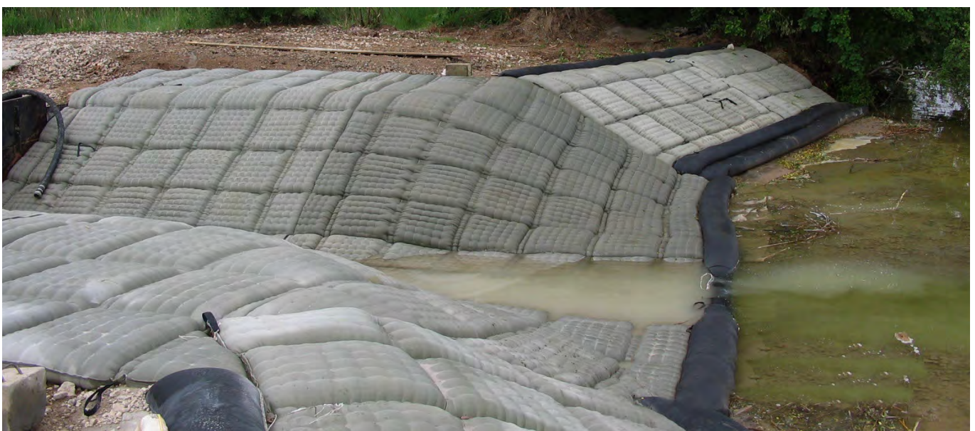
Instandgesetzter Auslass nach Fertigstellung (4)
