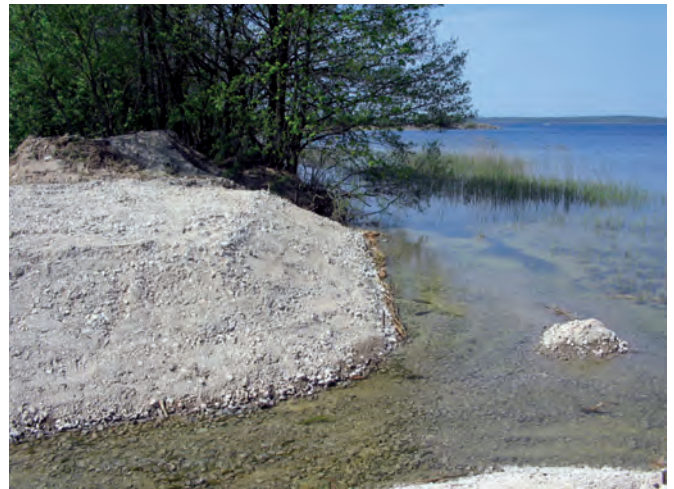
Vorbereitung der Böschung (Erdarbeiten) (2)
