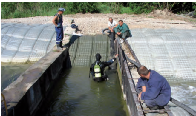
Einbau von Incomat® Flex unter Wasser
