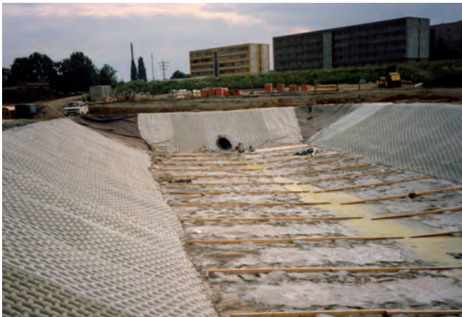
Speicherbecken mit Incomat® Crib während der Einbauphase (1)
