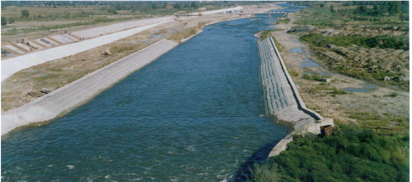
Böschungssicherung mit Incomat® Flex
