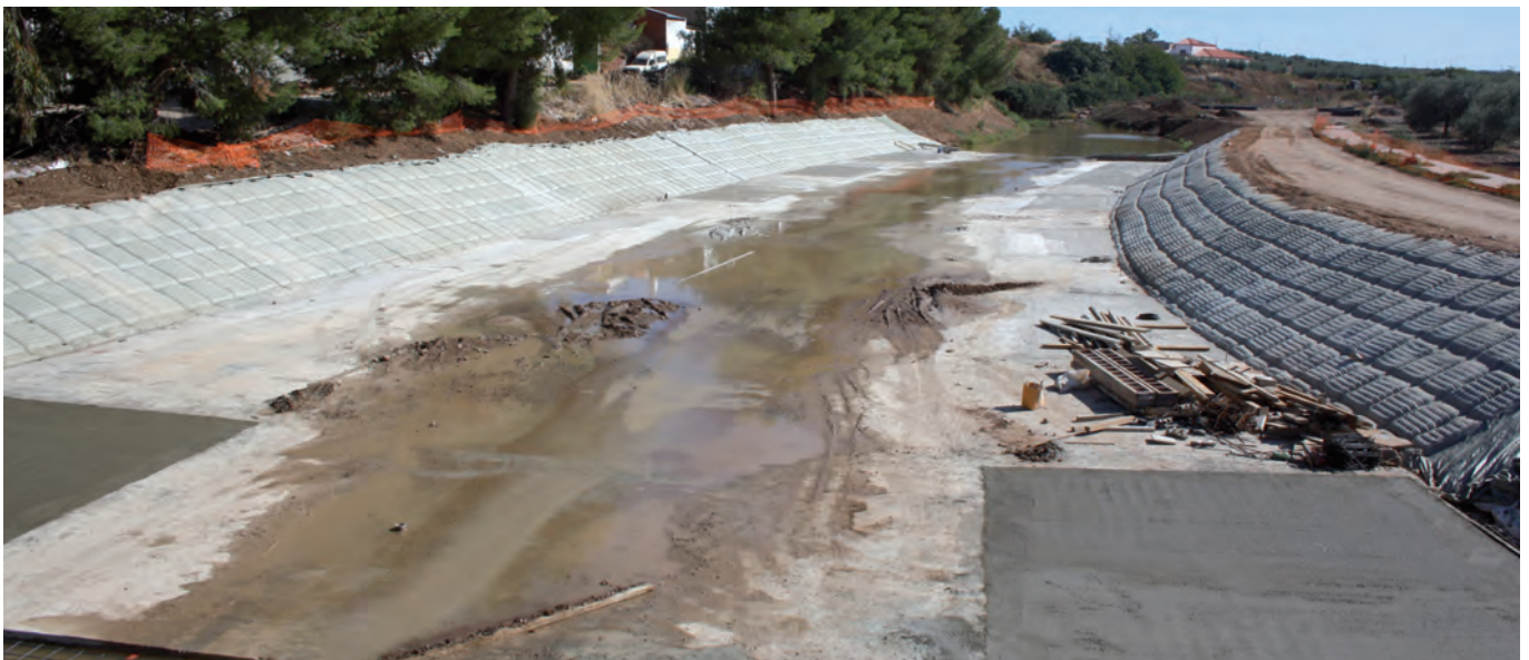
Böschungssicherung mit Incomat® Flex
