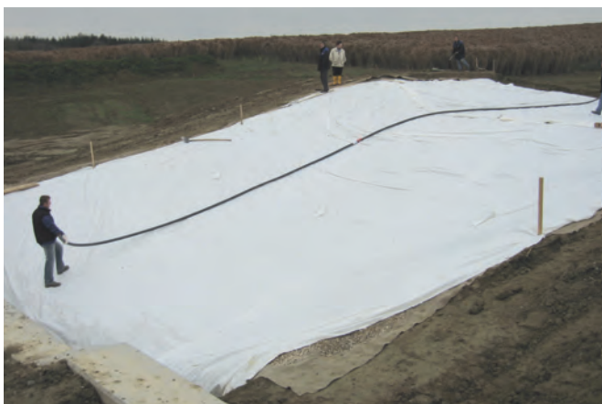
Incomat® FP wird für den Einbau vorbereitet
