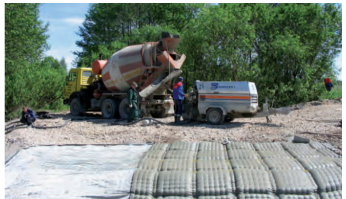
Einbau von Incomat® Flex
