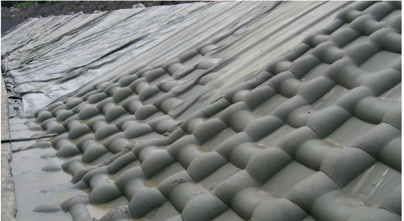
Einbau von Incomat® Crib
