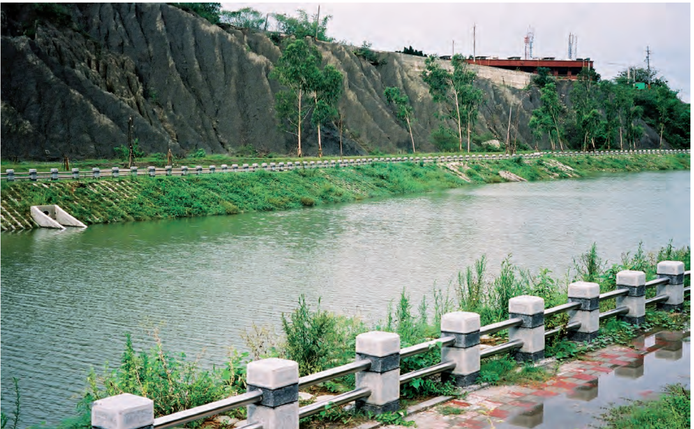
Begrünung nach Fertigstellung der Baumaßnahme (3)
