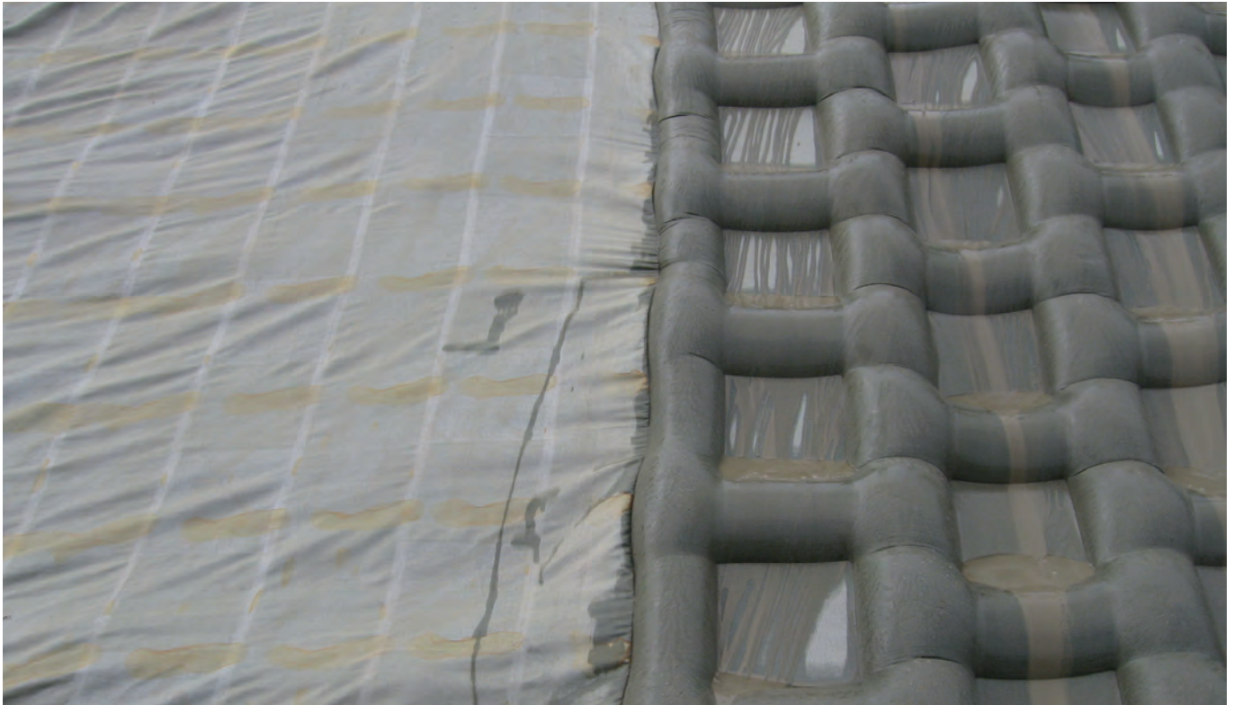
Nahtverbindung zwischen zwei Incomat® Crib Bahnen (links unbefüllt – rechts befüllt)
