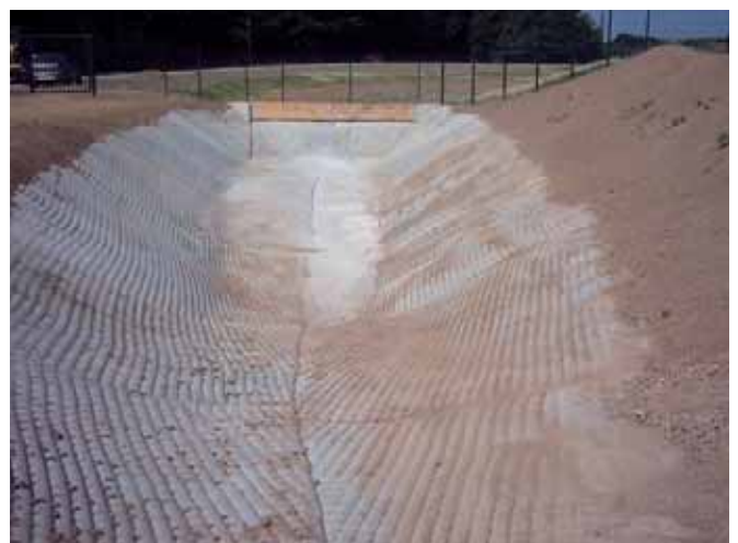
Après achèvement du chantier (3)
