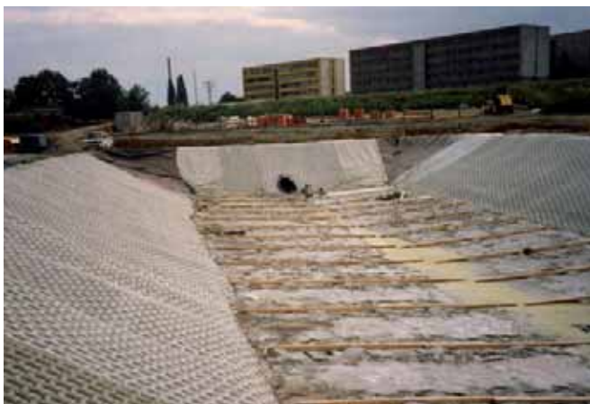
Bassin de rétention durant la pose d'Incomat® Crib (1)
