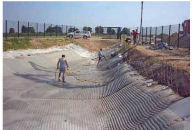
Remplissage d'Incomat® (1)
