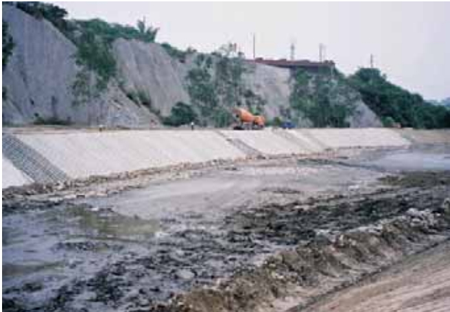
Phase de la pose (1)
