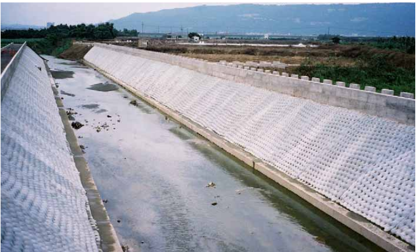
Canal de drainage avec habillage Incomat® FP
