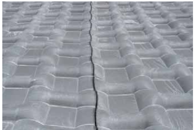
Liaison par des fermetures-éclair
