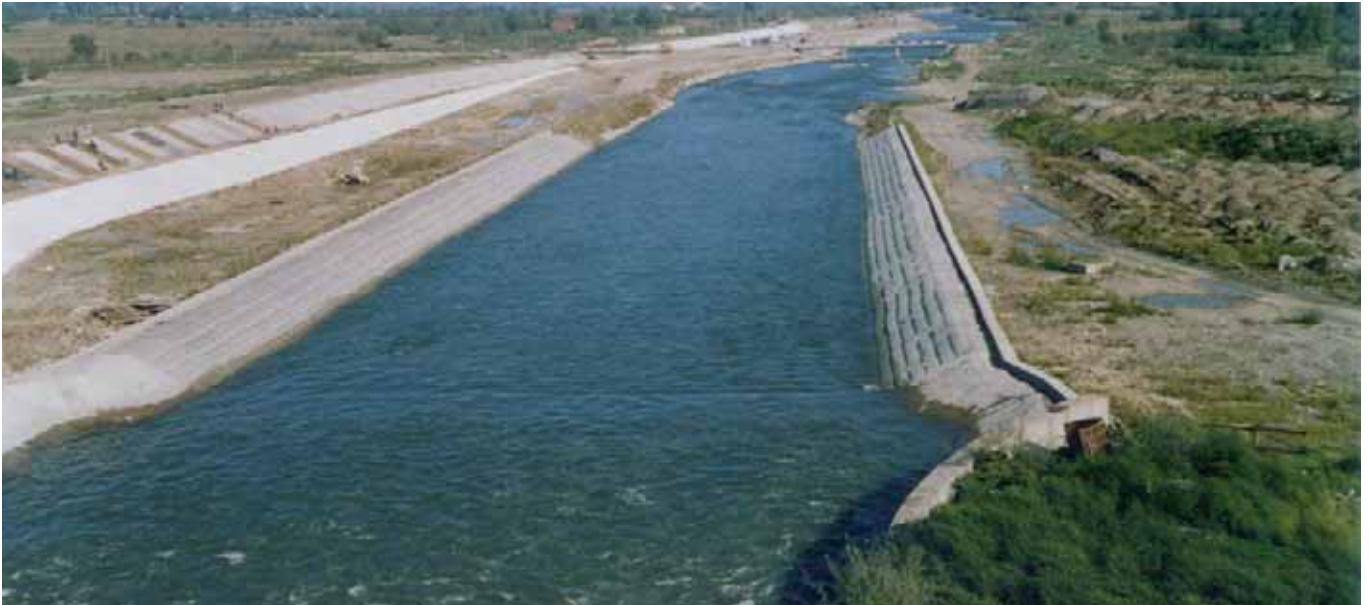
Stabilisation de talus avec Incomat® Flex
