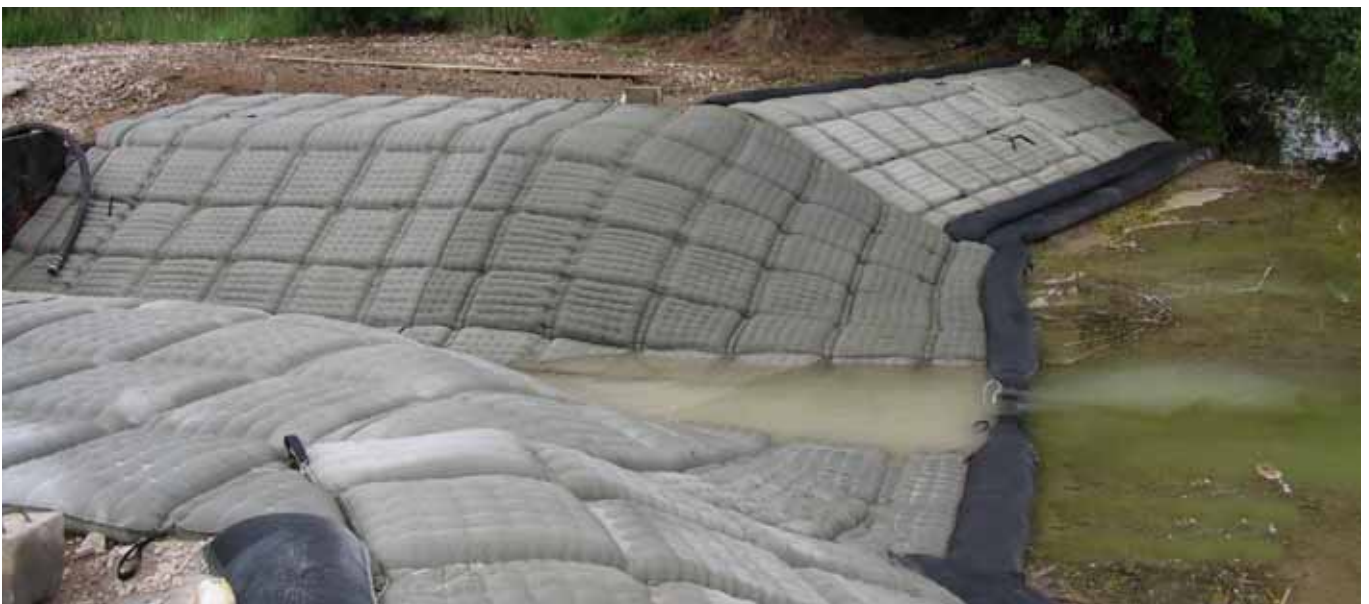
Ouvrage de déversement après achèvement du chantier (4)
