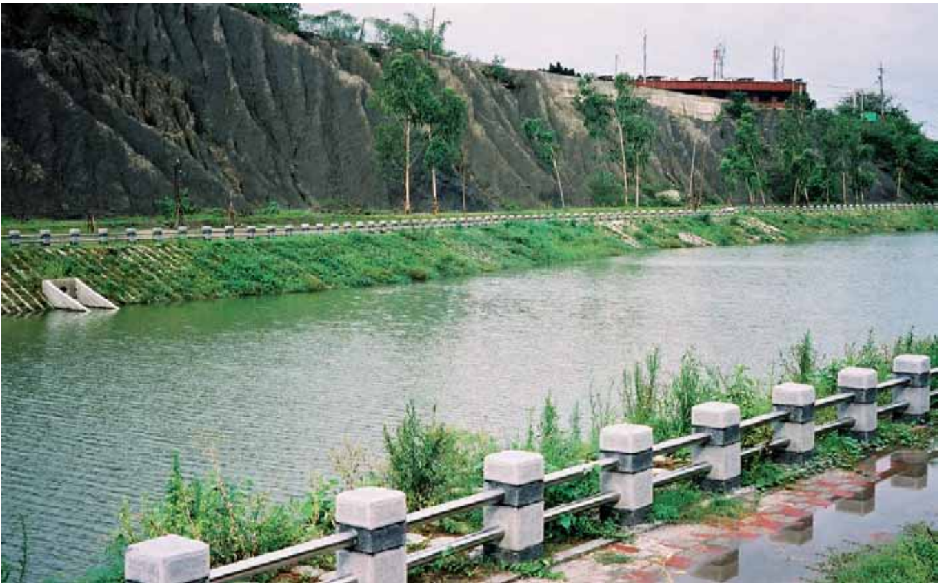
Végétalisation après achèvement des travaux (3)
