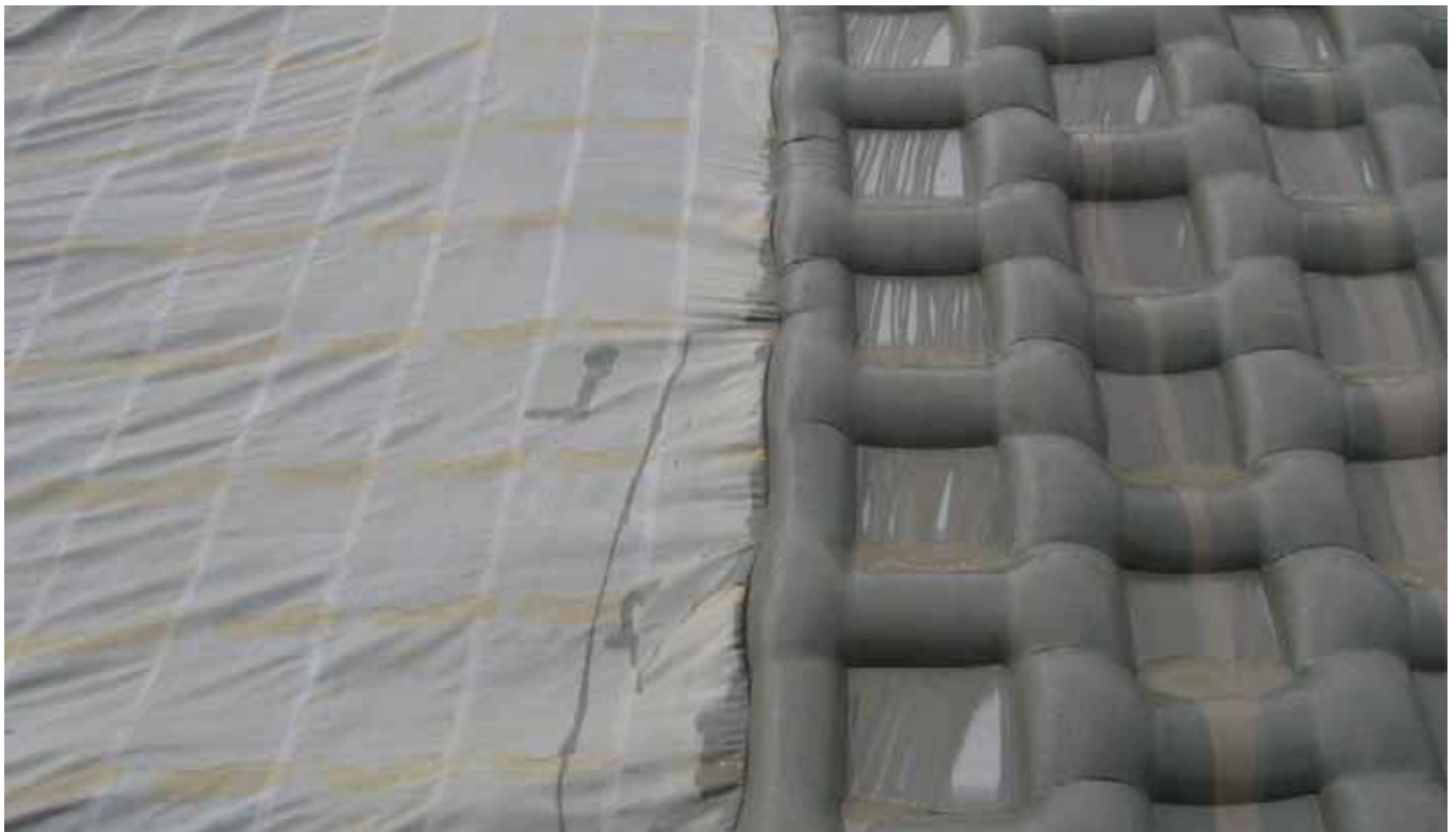
Liaison par couture de deux lés Incomat® Crib (à gauche : non rempli – à droite : rempli)
