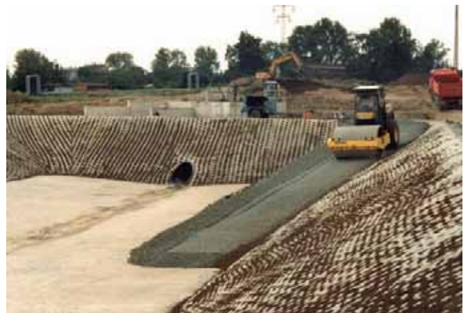
Bassin avec matelas Incomat® Crib couvert de terre
