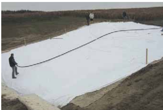
Préparation d' Incomat® FP avant la pose
