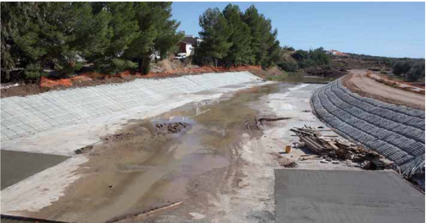
Stabilisation de talus avec Incomat® Flex
