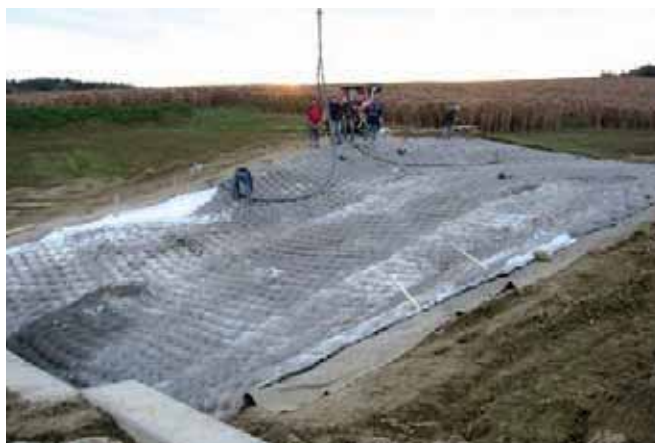
Incomat® FP après le remplissage du béton
