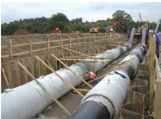
Incomat® Standard utilisé comme enveloppe et protection contre la sous-pression hydrostatique sur un ouvrage hydraulique en siphon
