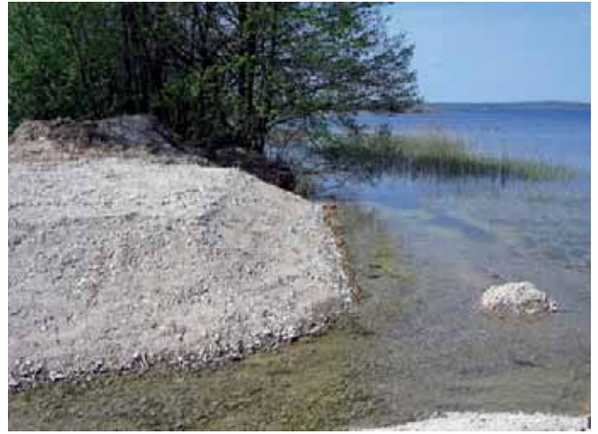
Préparation du talus (terrassement) (2)
