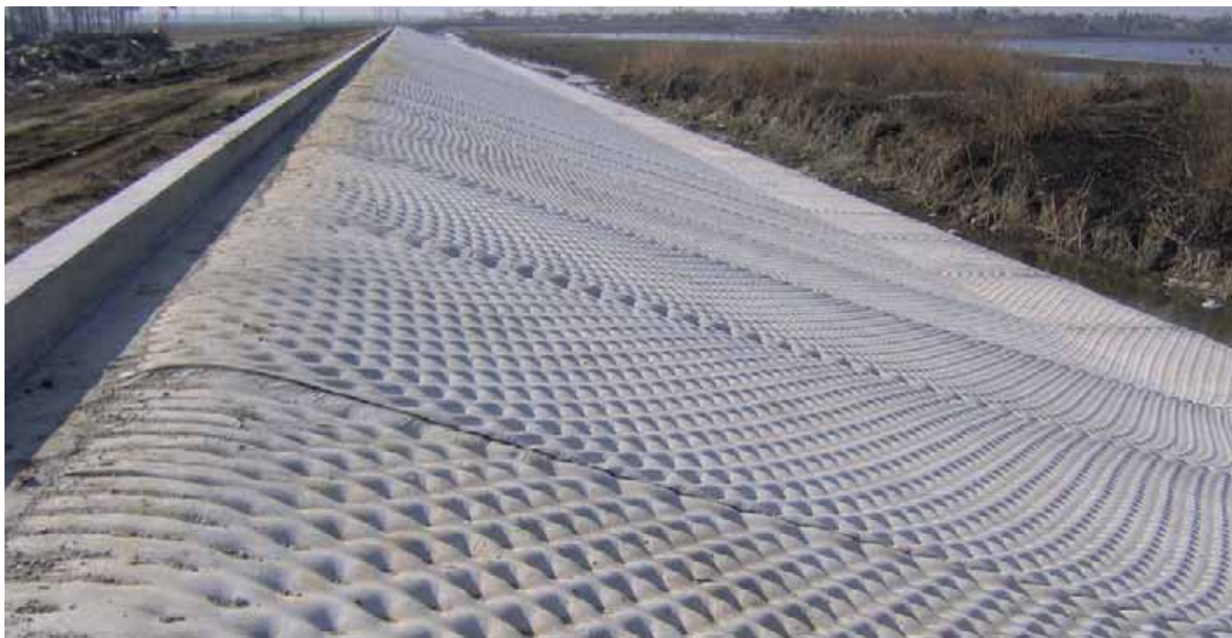
Stabilisation de talus avec Incomat® FP
