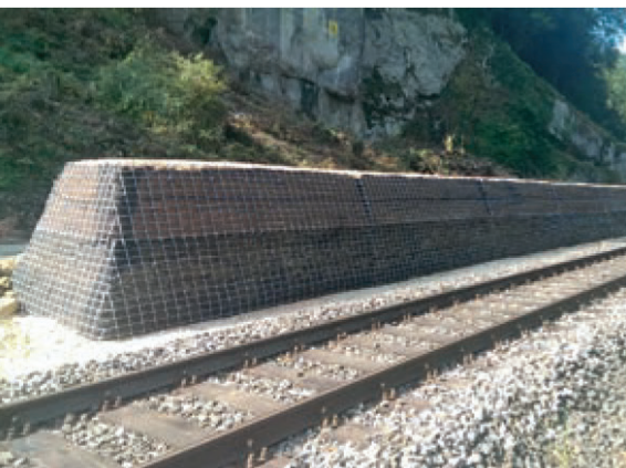
Ouvrage n° 31, réalisé avec le système Stebo pour talus abrupts à Dägenauer BL.
