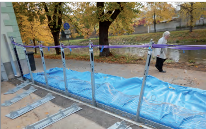
Zustand während des Aufbaus
