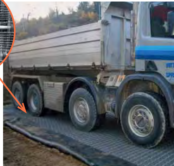
«MammothMat» ist ein mit Federstahlstangen und galvanisierten Stahldrähten verstärktes Geogewebe. Hier im Einsatz als mobile Baustrasse in Schlieren ZH.
