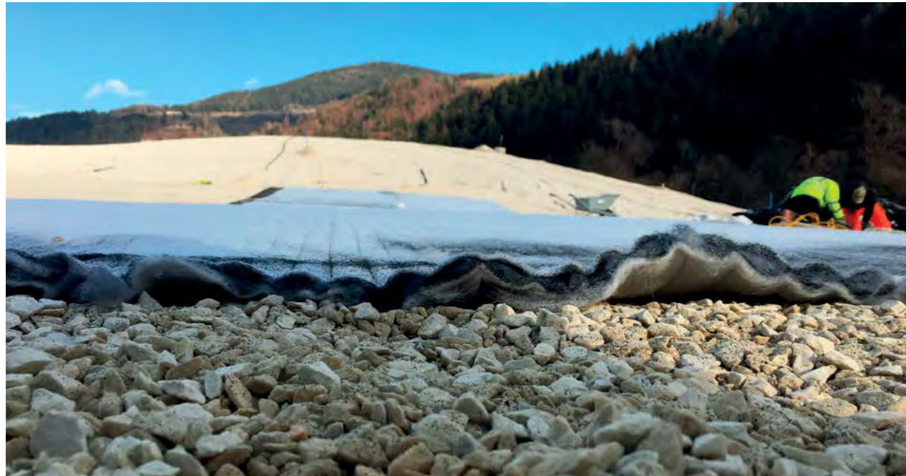
Schadstoffbarriere in der Altlastensanierung
