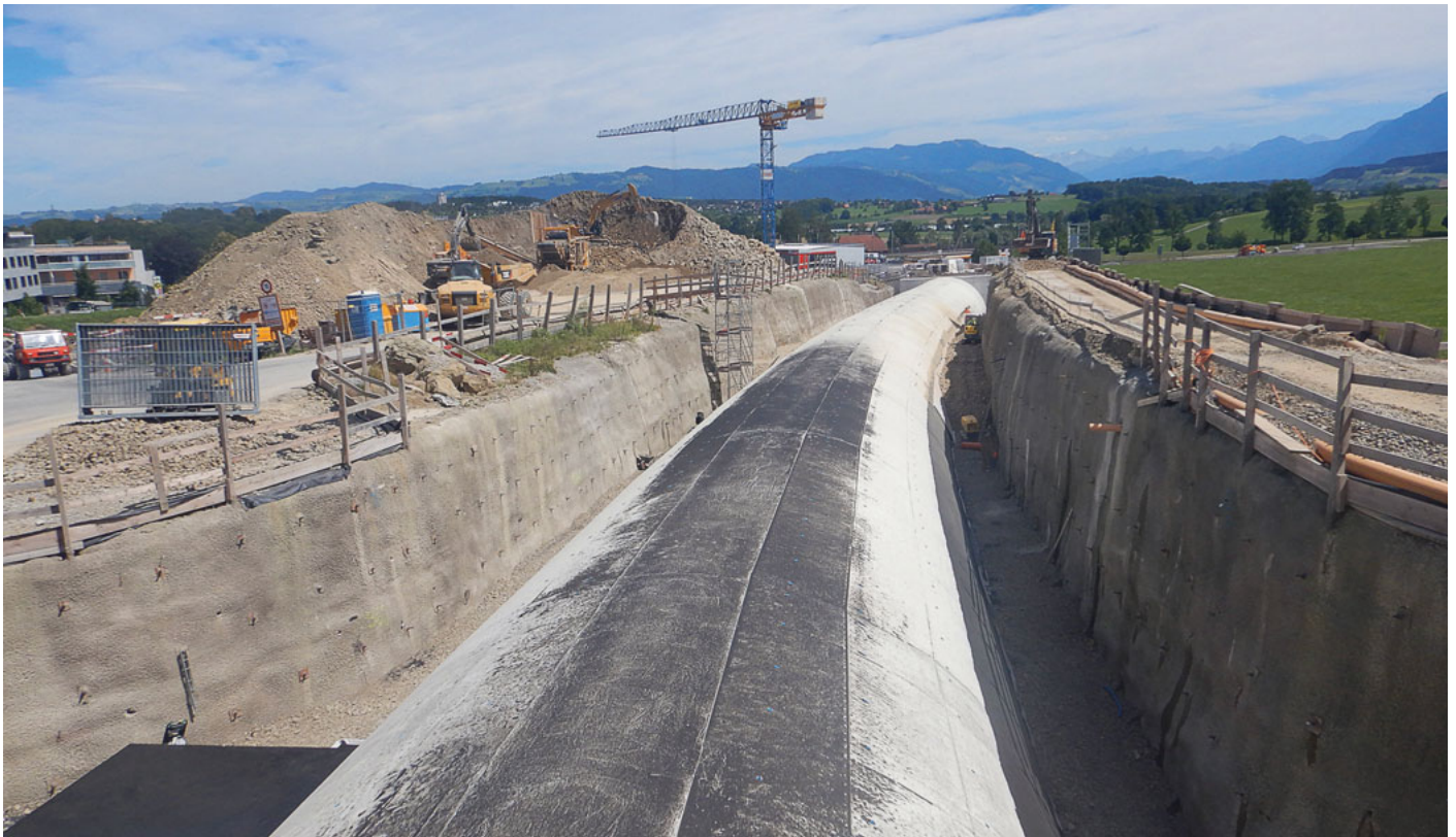
Gewölbe des Tagbautunnels Letten, Sins.
