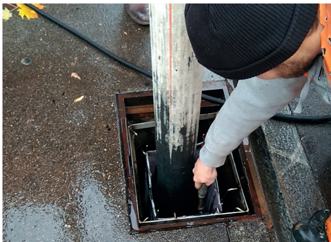
Aussaugen des geotextilen Filtersacks
