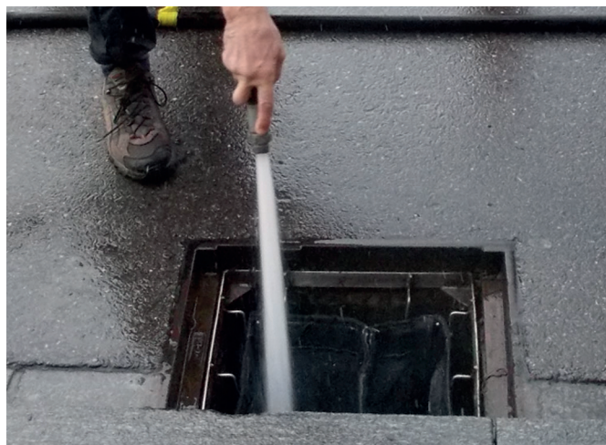
Spülen des geotextilen Filtersacks
