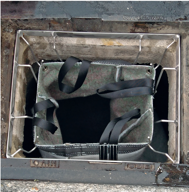
Tragkonstruktion und geotextiler Filtersack
