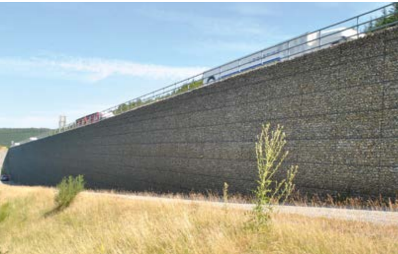
Ausbau der A3, Frankfurt/Main – Würzburg Deutschland | Dammverbreiterung für den 6-spurigen Ausbau westlich und östlich der Haseltalbrücke – Bis zu 13 m hohe Vollgabionenwände – Selbsttragende KBE-Stützwand mit Gabionen als rein optische Verblendung (Passivbauweise).
