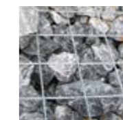
Druckstabile, frostsichere Steinfüllung
