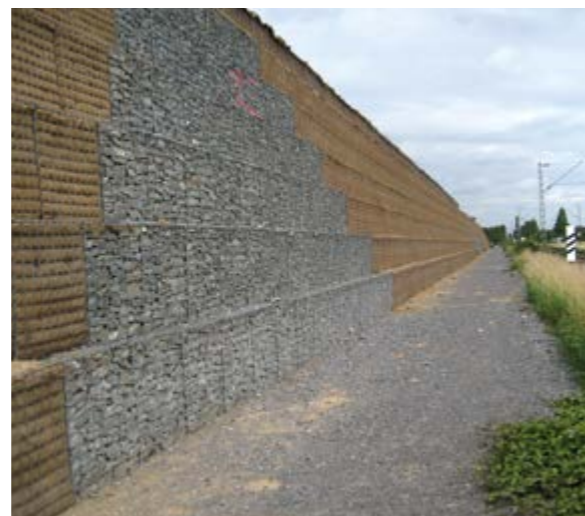
Lärmschutzwand für ein Wohngebiet in Neuss Deutschland | Bebauungsgebiet an Bahnstrecke und Kreisstraße – Kombination Vollgabionenwand zu Gleisen, Naturböschung zur Wohnbebauung – Befüllung der Gabionen mit Steinen, aber auch mit Erde + Bepflanzung – Höhe 10 m und 68^\circ gleisseitiger Neigungswinkel.
